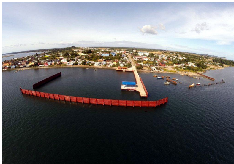
Figura 15: Construcción Infraestructura Portuaria Caleta Maullín, Región de Los Lagos
