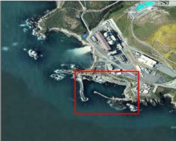
Sistema de captación en la línea de la costa
