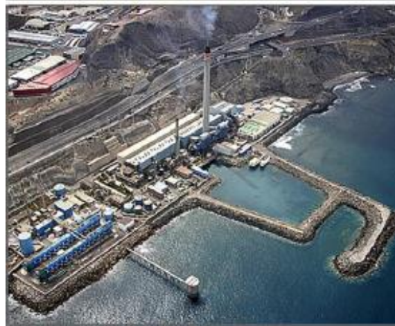
Sistema de captación en la línea de la costa con dique poroso
