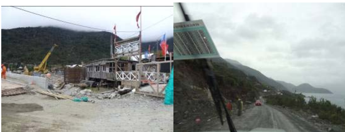
Figura 35. Ruta CH-7, y trabajos en Rampa Caleta La Arena
