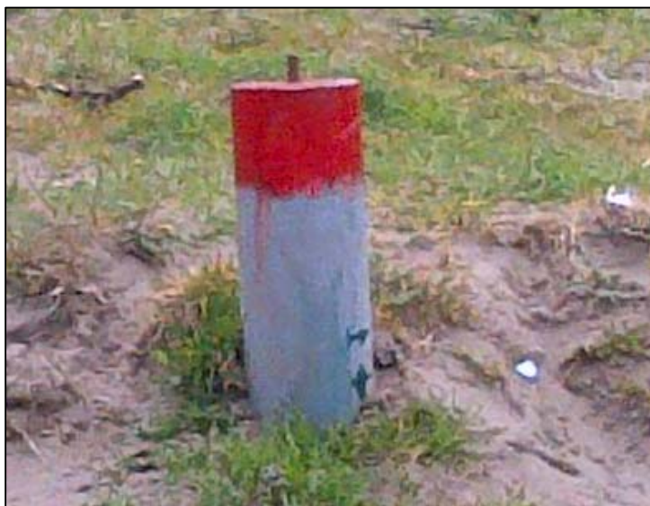
Foto 37. Monolito que no cumple las condiciones de calidad.
