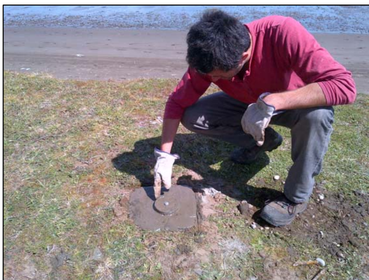
Foto 38: Construcción y reemplazo de nuevos monolitos
