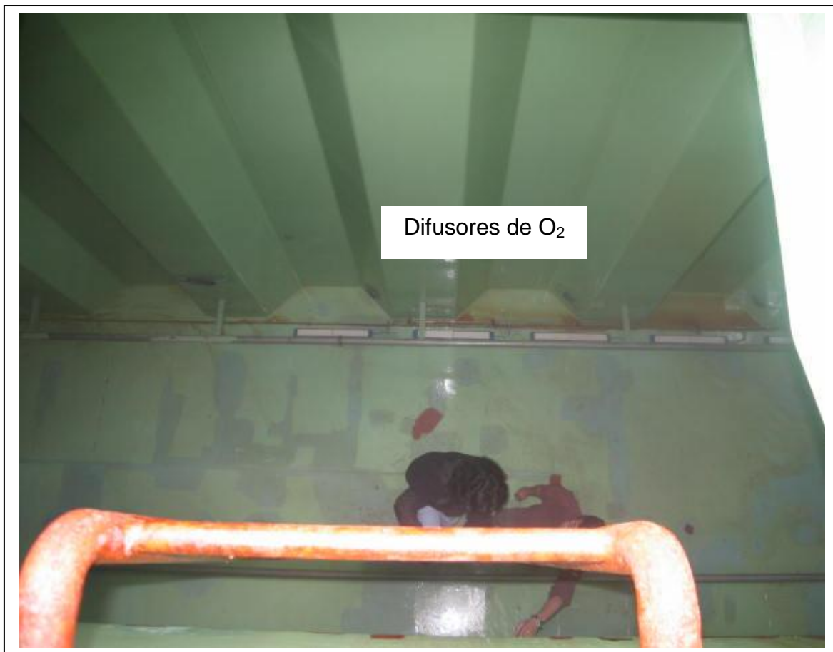
Figura 17. Fotografía del interior de la bodega de estribor de la nave wellboat Patag3n IV en la que se observan la posici3n de los difusores de oxígeno en el piso de la bodega. En primer plano se observa la escalera de acceso de entrada a la bodega a través de la escotilla (Foto: Nicole Pesse).
