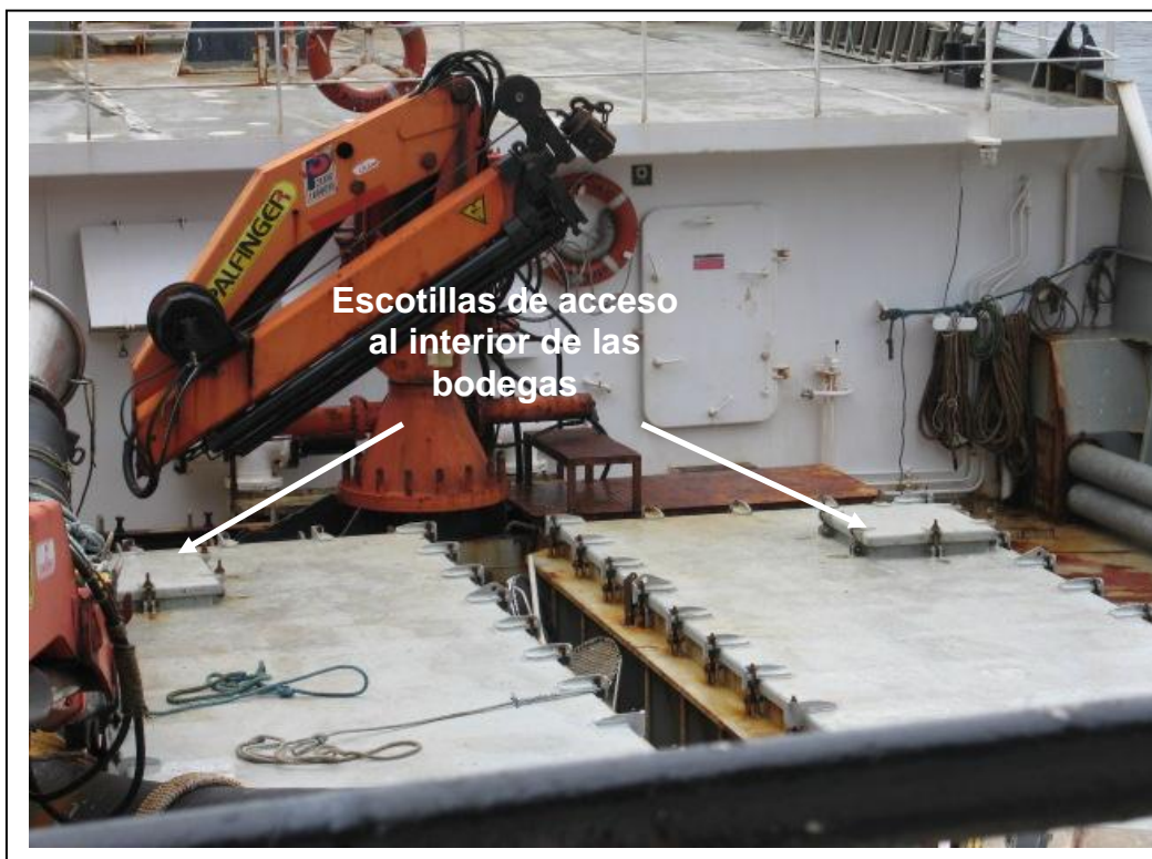
Figura 19. Escotillas de acceso al interior de las bodegas de babor y estribor para el personal de la nave (Foto: Nicole Pesse).
