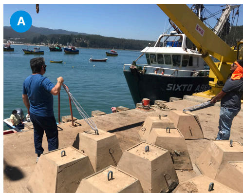
FIGURA 11 Traslado e instalación de muertos o fondeos
