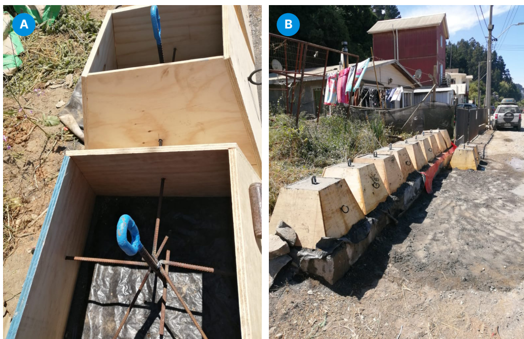
FIGURA 10 Fabricación de fondeos o “muertos” para la instalación de los cultivos
