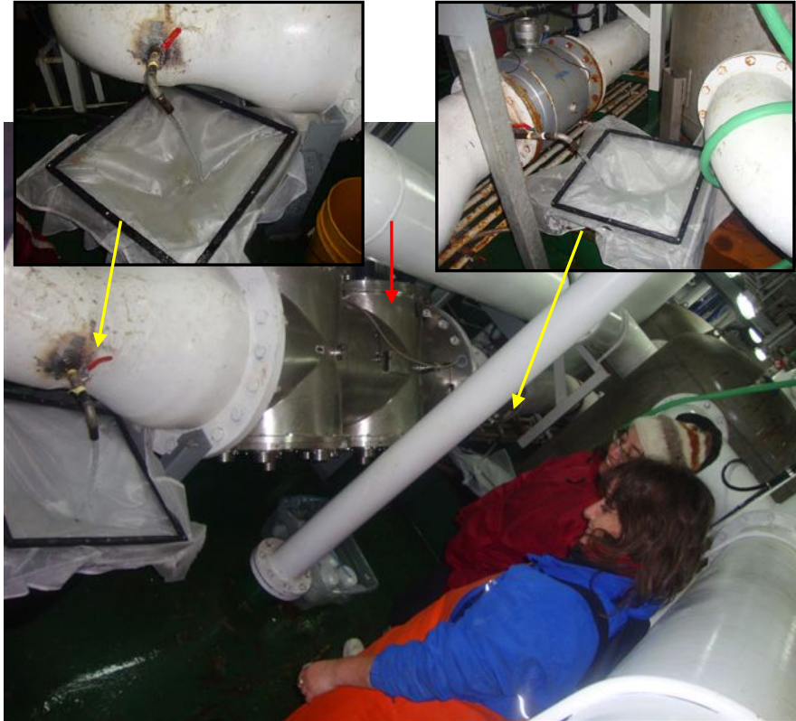
Figura 4. Muestreo de agua a trav3s de llaves de paso o despiches (flechas amarillas) en las secciones pre y post reactor , situados en los extremos del reactor UV, respectivamente (sistema de acero inoxidable central, flecha roja).
