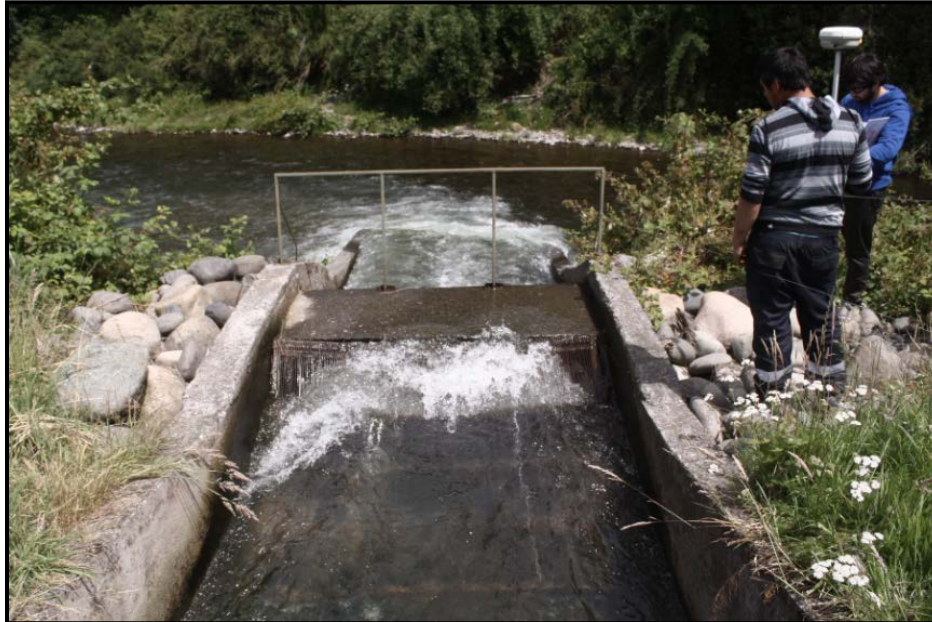
Figura N°28. Ejemplo Medición Descarga, Piscicultura Llaima-Cherqén (Melipeuco). Fuente: Ingeland.
