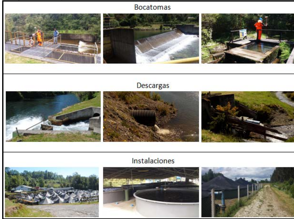
Figura N°14. Ejemplo Bocatomas, Descargas e Instalaciones. Fuente: Ingeland.
