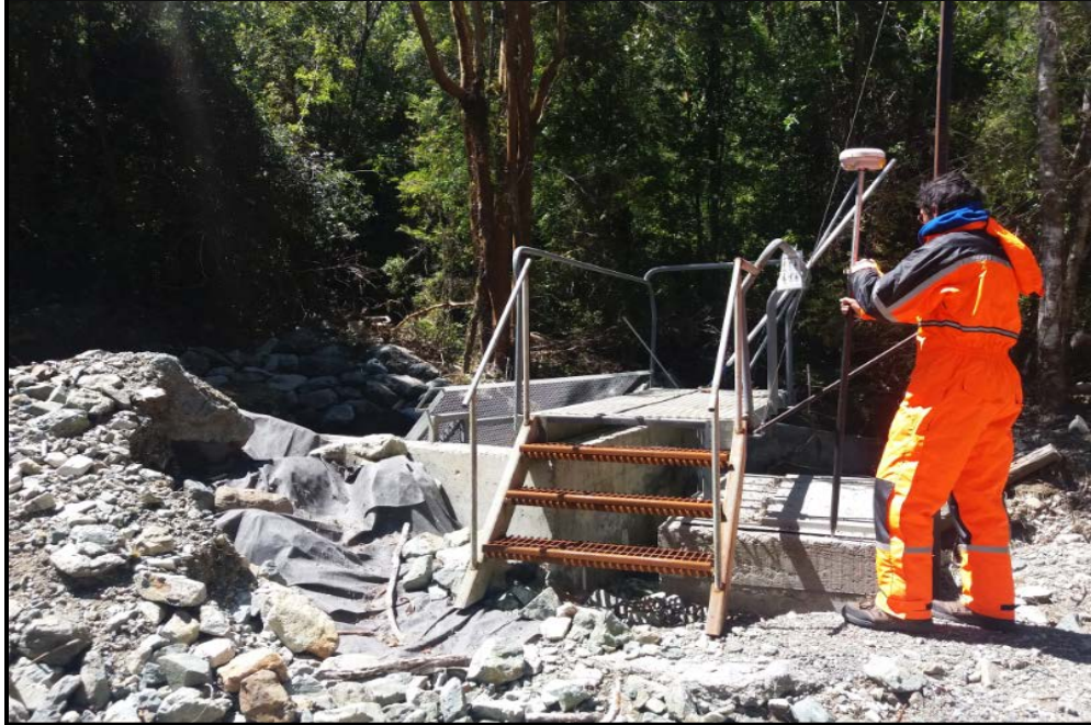
Figura N°35. Ejemplo Medición Bocatoma, Piscicultura Cuyamco. Fuente: Ingeland.
